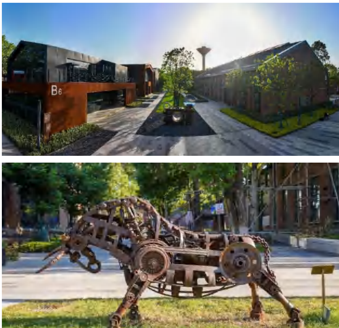
图 37：武钢“云谷”606 对厂房、工业构件进行修缮及重构
