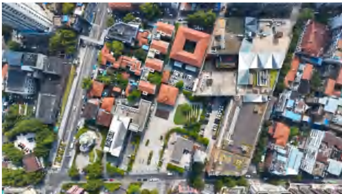
图 88：平和打包厂地块航拍图
