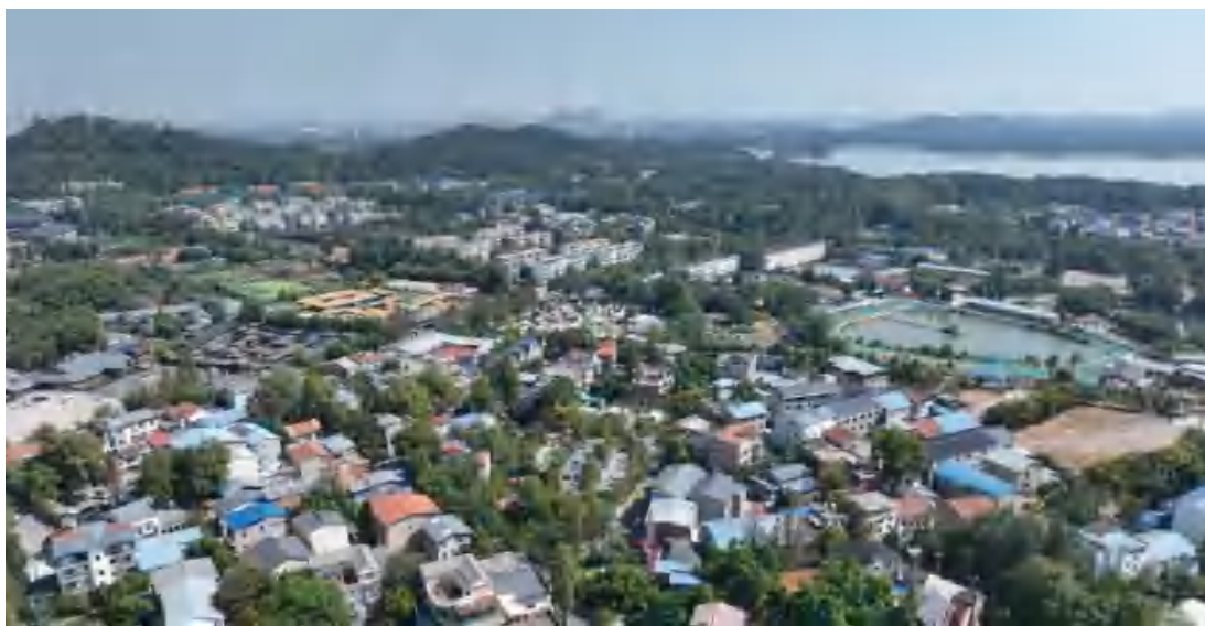
图 51：东湖大李村微更新改造后面貌
